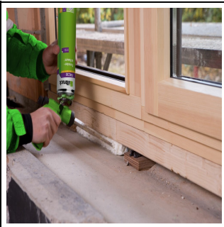
1. Bild: Verarbeitung der Fensteranschlussfuge mit FM220.
